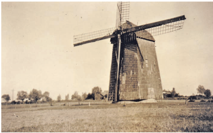
Die Windmühle Joh. Reisgies. Schwentwokarren. Sie wurde 1983 abgerissen.
