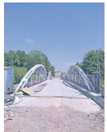
Aufnahme von W nach O. Neben dem linken Bogen ist der Rad- und Fußweg zu erkennen.
